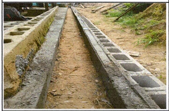
Foto 4: #-3. Mejoramiento de Cuneta de concreto.
