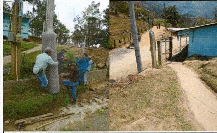
Foto 1: #-1. Mejoramiento de Cerco o muro perimetral.
